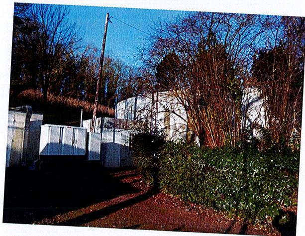
Situé sur la commune de Houlgate, Avenue Foucher de Careil, ce réservoir est constitué de trois cuves, une de 1000m<sup>3</sup> semi-enterrée et deux de 500m<sup>3</sup> enterrées.
