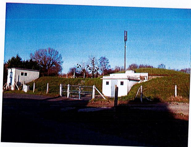
Situé sur la commune de Houlgate, route de la Corniche, ce réservoir est constitué de deux cuves semi-enterrées dont la capacité de stockage est de 1000m<sup>3</sup> + 100m<sup>3</sup>.
